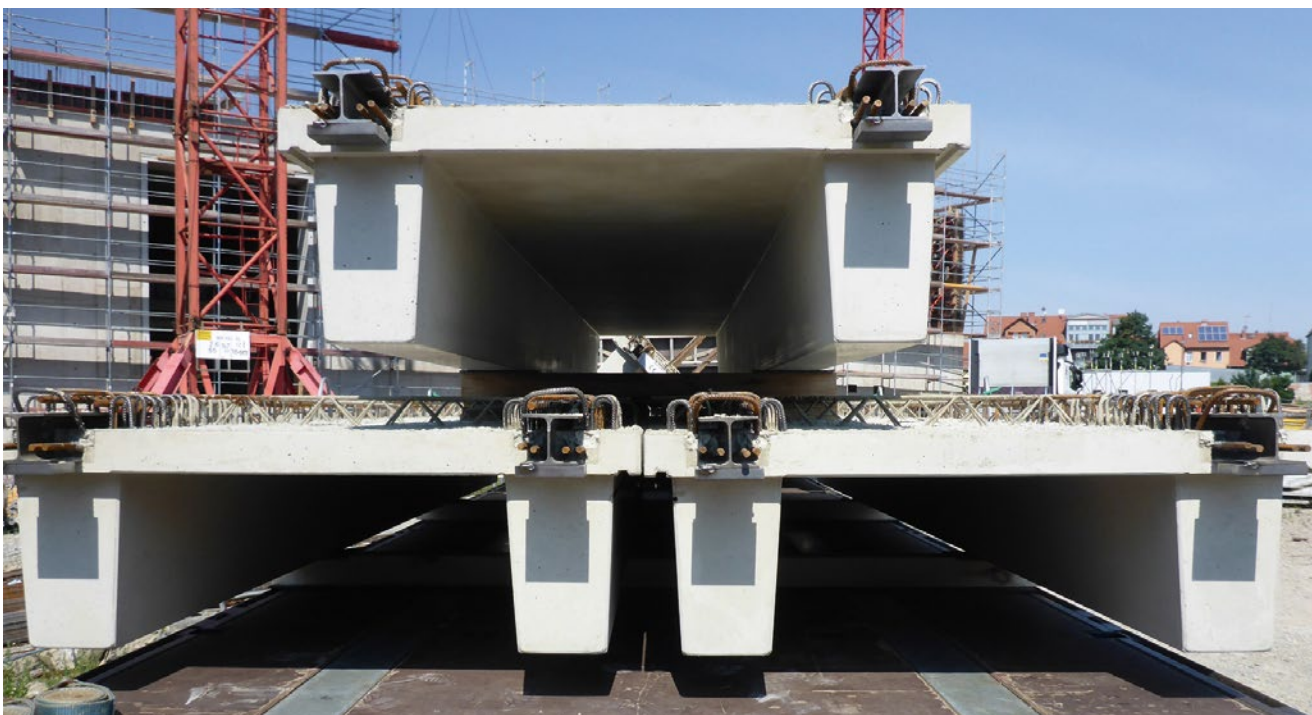
Anlieferung der II-Platten für die Rippendecken
