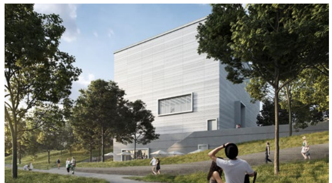
Südansicht (noch mit geplanter Glasfassade)
