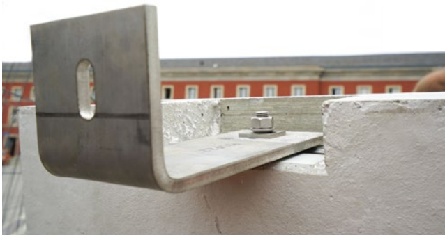
Lasche für Befestigung Fassade/Stahlbetonwand Foto: Bärbel Rechenbach
