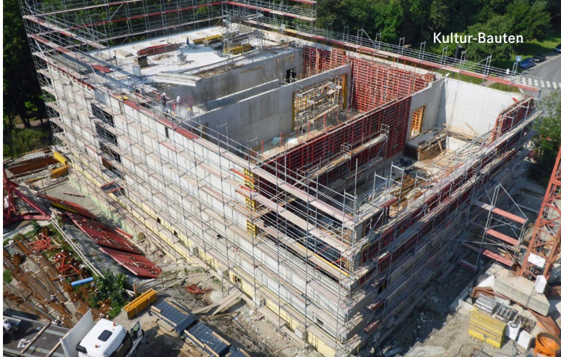
Während des Rohbaus Foto: ARGE Tragwerksplanung Bauhausmuseum Weimar
